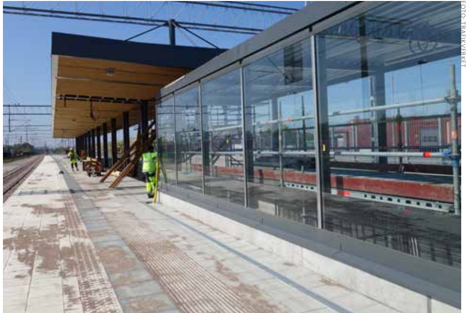
Burlövs nya station som håller på att växa fram. Bilden är tagen i maj 2020.
