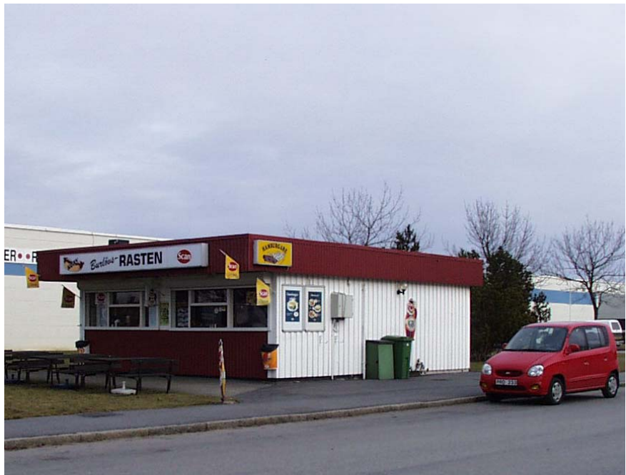
Befintlig byggnad på Tågarp 15:1.
