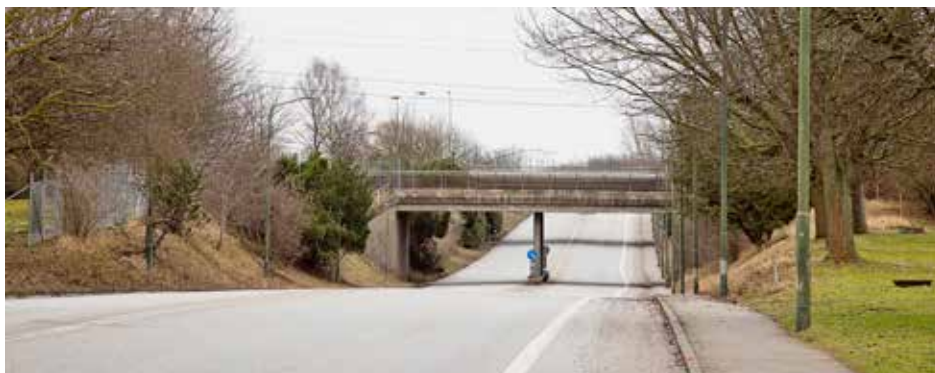
Trafikverket bygger två järnvägsbroar över Kronetorpsvägen.
