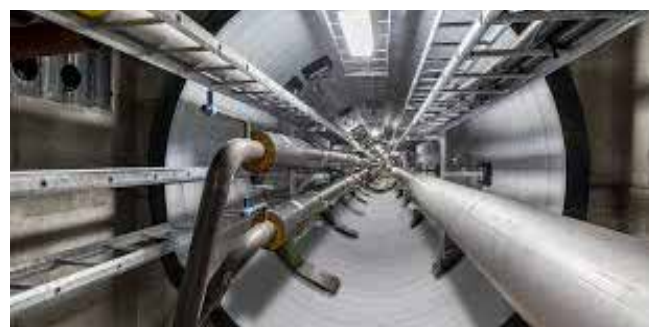
Infrakulvert. Bild tekniskaverken.se
