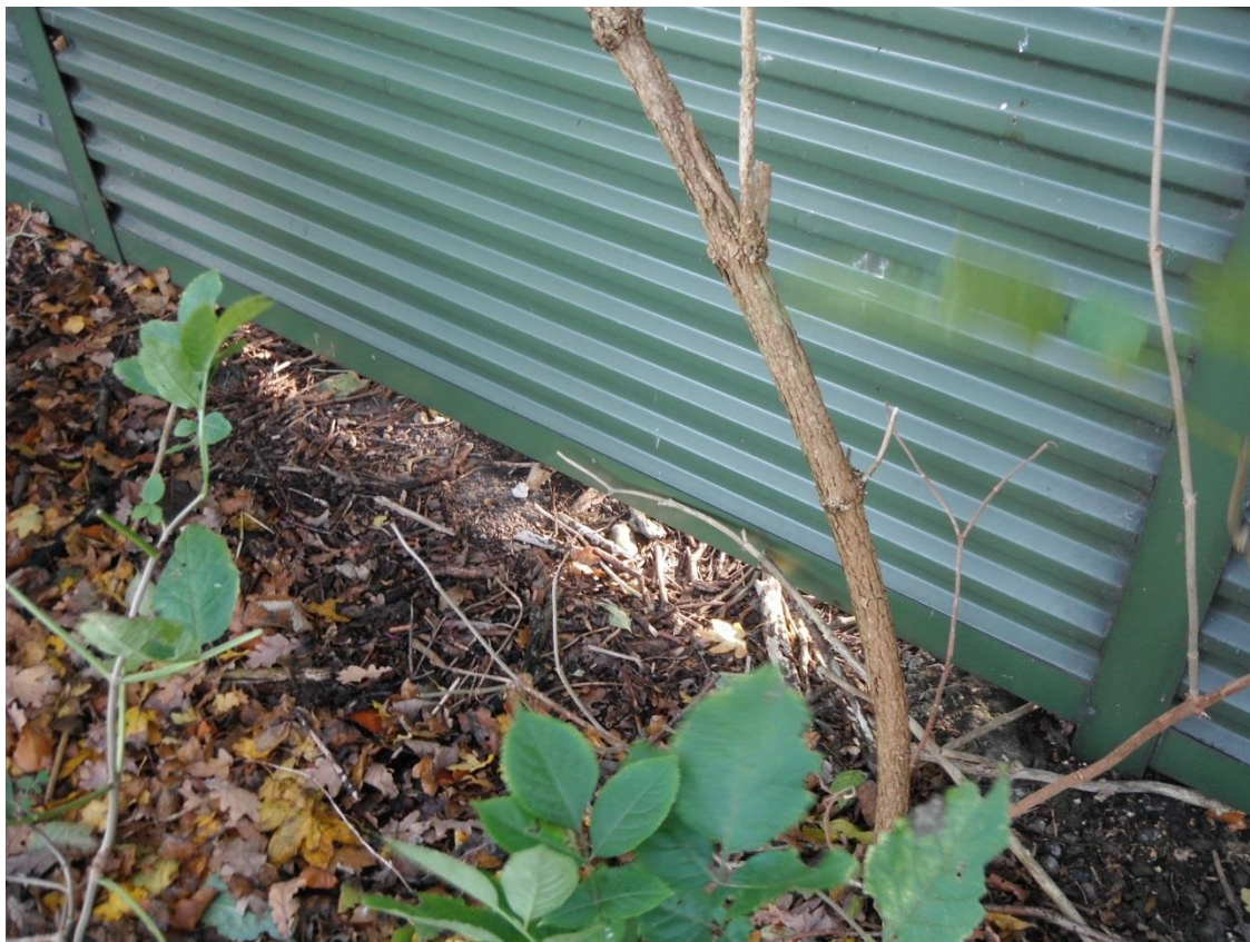
Bilaga 3. Glipa mot marken under bullerskärm nr 3 (Granebackens koloniförening)
