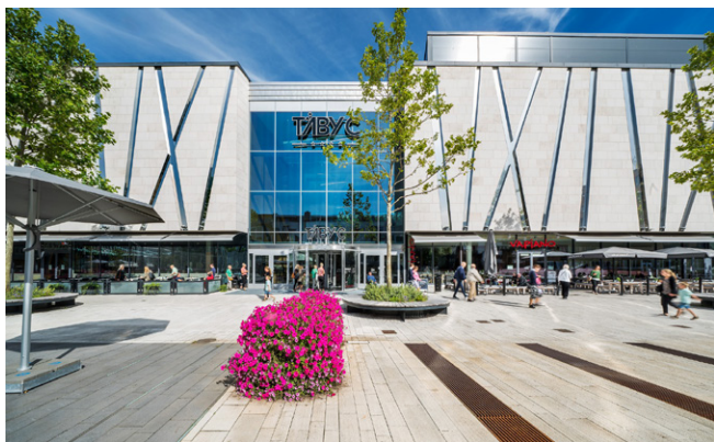
Fasad längre än 30 m delas upp i olika volymer och genom fönsterpartier. Reklam- och identitetsskyltar hålls inom fasader. Foto: Täby Centrum, Lars Clason photography.
