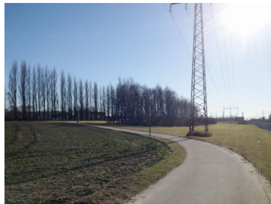
Teknisk infrastruktur och bollplan. Vy från norr.
