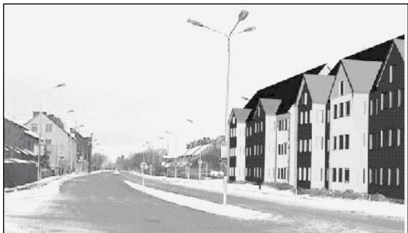
Vy från sydost, Lommavägen
