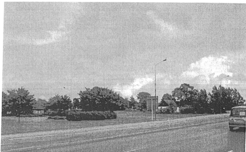
Foto från Kronetorpssvägen in över planområdet. Daghemmet skymtar i vänstra kanten av bilden.
