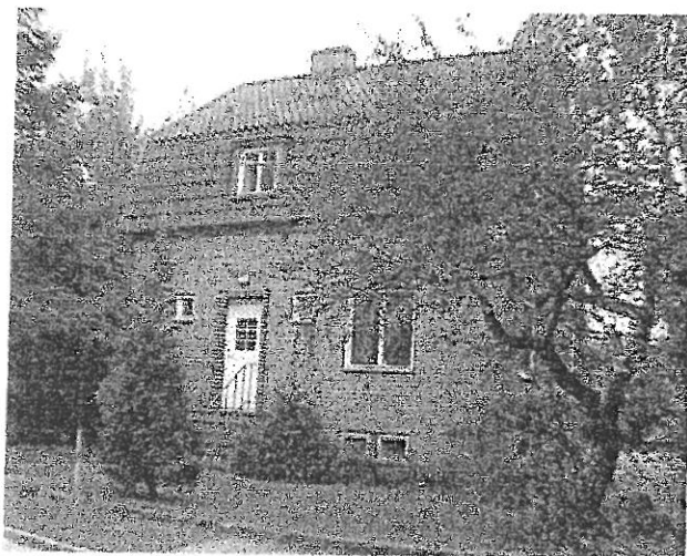
Befintlig byggnad på Arlov 19:42
