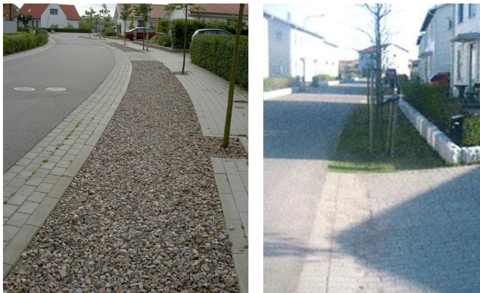
Figur 15. Exempel på kross- (vänster, (Ramboll, 2020-10-21)) och gräsdiken (höger, (Mitta AB, 2019-11-13)).
