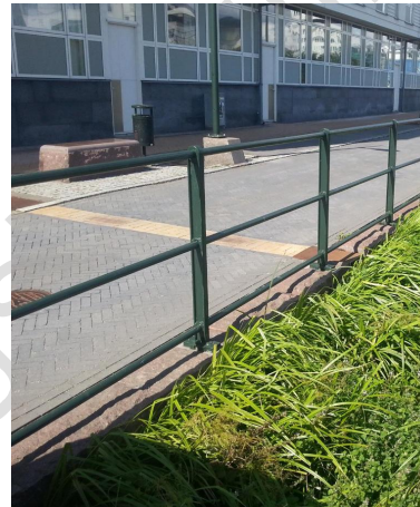
Figur 18. Exempel på öppet ledningssystemet som inte hindrar framkomligheten (Ramboll, 2020-10-21).
