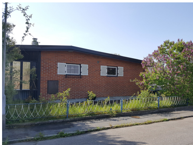
Enplansvilla med mycket flackt takfall, fasadmateriäl i rött tegel.
