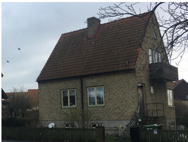
Villa med brant takfall med fasad i gult tegel.
