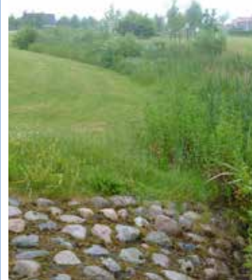
Parkmark med dagvattendike i Lerviksparken, Lomma.
