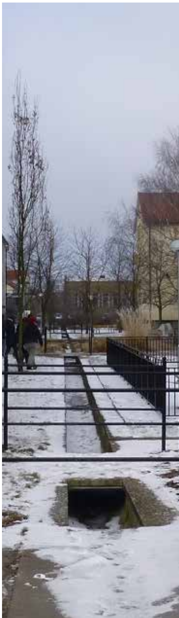
Dagvattenränna i Augustenborg, Malmö.
