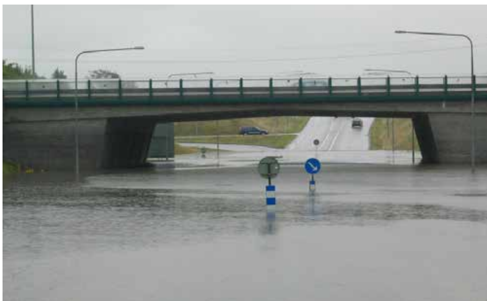
Översvämning under tunnel vid Kronetorpssvägen, 2007. I vattnet står en bil som är helt under ytan.
