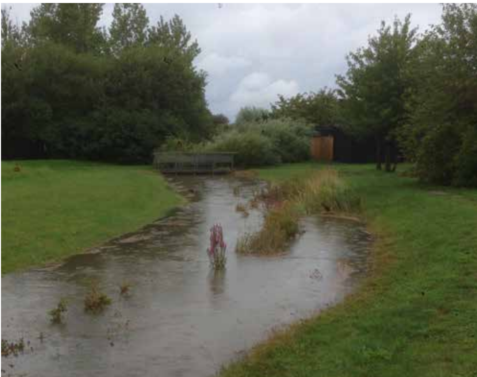
Bro över dagvattenanläggning, Fjärilsdiket, Malmö.
