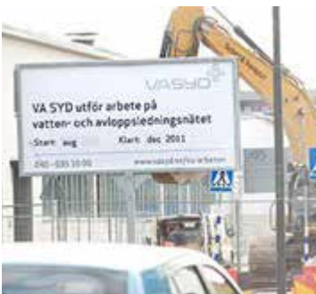
VA SYD projekterar och bygger dagvattenledningar i allmän platsmark.
