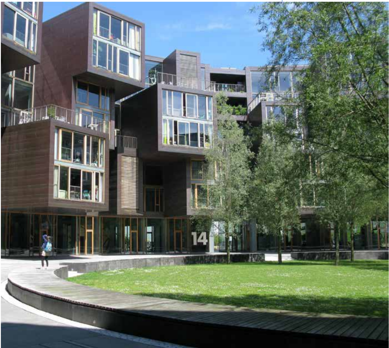
Dagvattnet från denna innergård samlas i den skålade gräsytan i mitten av kvarteret, Tietgenkollegiet, Örestad, Danmark.
