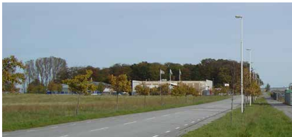
Väg med svackdike, till höger i bilden, Stora Bernstorp.
