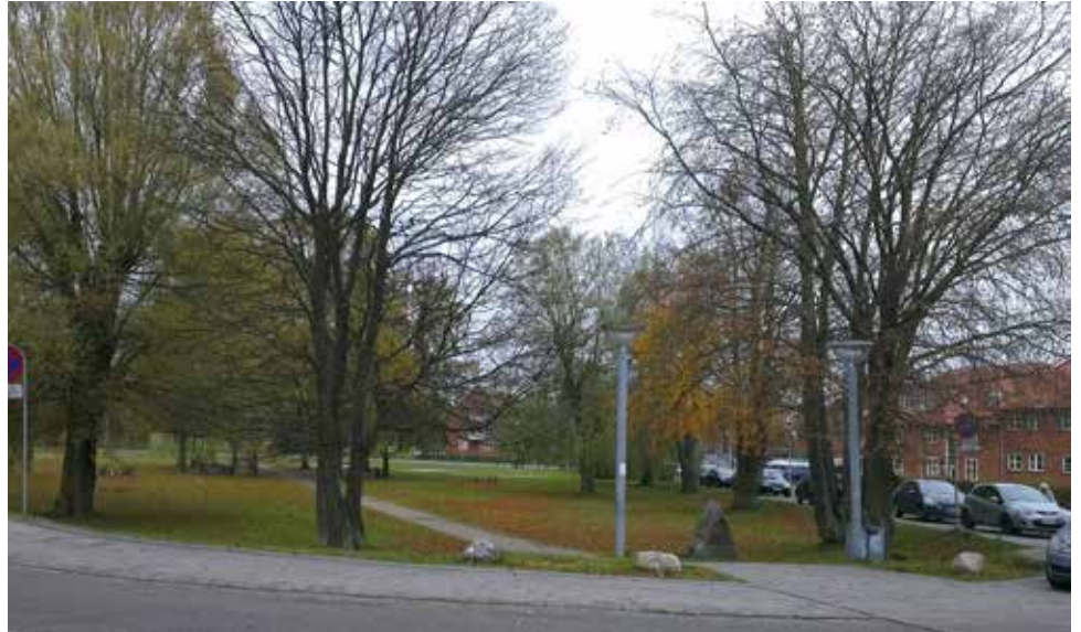
Park som fungerar som fördröjningsmagasin vid stora regn då den ligger lägre än omkringliggande vägar och bebyggelse.
