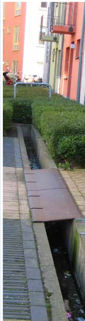
Dagvattenränna i Västra hamnen, Malmö.
