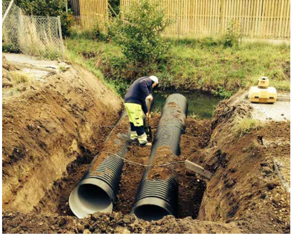
Anläggning av bräddledningar för att minska uppdamning från Alnarpsån vid bron i Åkarp.
