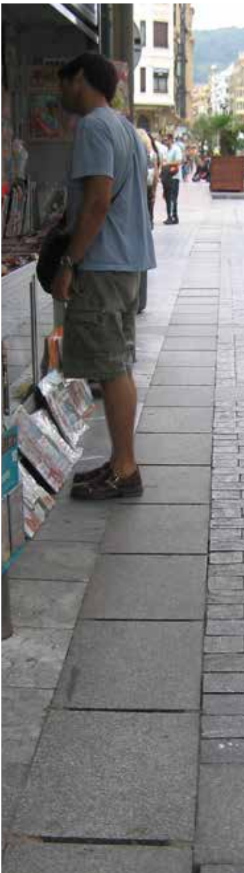
Dagvattenränna i Bilbao, Spanien.
