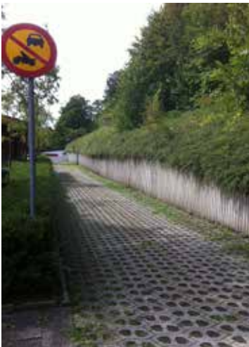
Brandvägar och vägar som sällan används kan med fördel utformas genomsläppliga med till exempel gräsarmeringssten, infart till handikappentré, vårdcentralen, Ystad.
